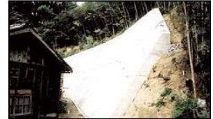
勝佐急傾斜地崩壊対策
